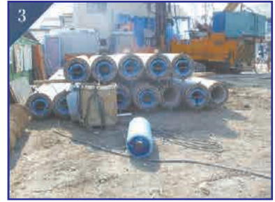
ミルクトレールの取付が完了した杭
