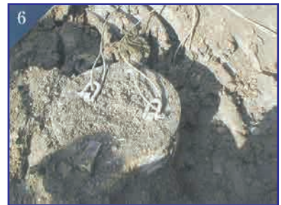
取付用カンザシ筋を外しミルクト レールの上部金具に6分のシャッ クルを通して4分のワイヤーを掛 ける。
